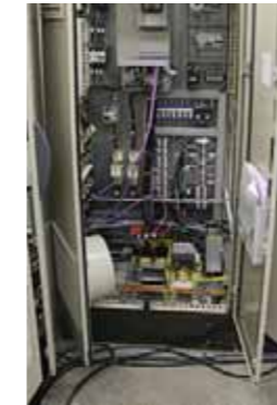
Рис. 4. Шкаф управления электроприводом передвижения крана г/п 90 т
